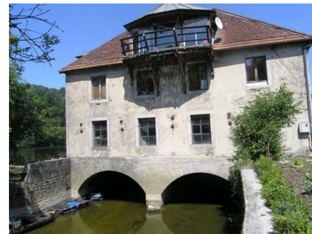
Sortie de la chambre d'eau et du canal de décharge
