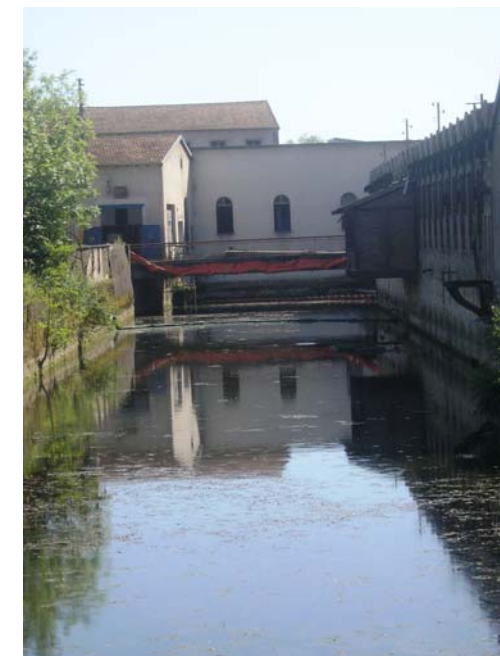
Canal de fuite
