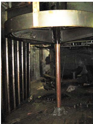
Ancien arbre de transmission
