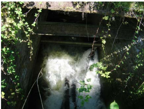
Ancienne implantation de la turbine
