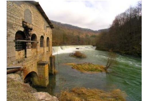
Vue du barrage et du bâtiment abritant la prise d'eau.
