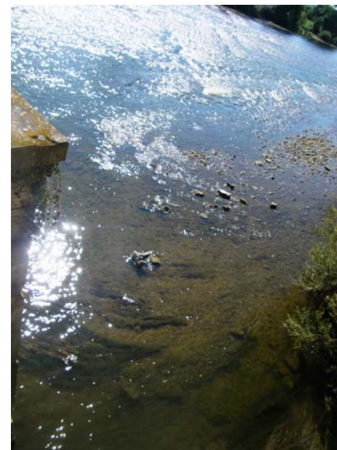
Canal de fuite et restitution au Doubs
