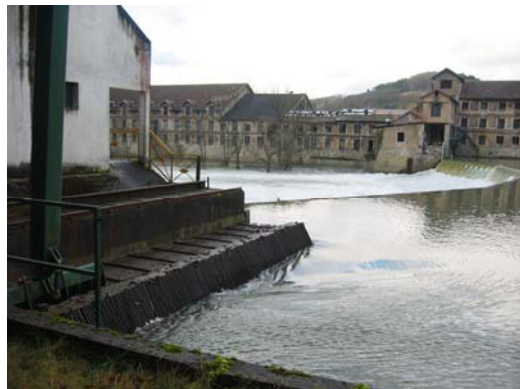
Prise d'eau turbine Rive Gauche
