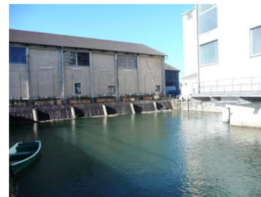
Prise d'eau avec dégrilleur
