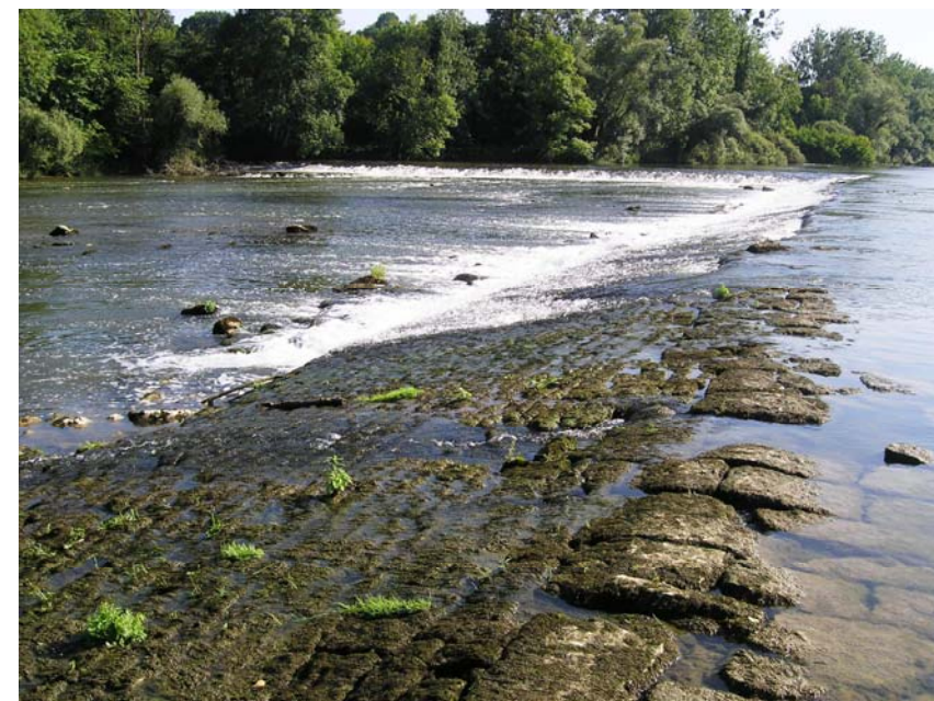
Barrage de Clermoulin
