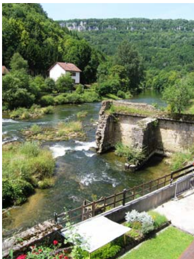
Vestiges de l'ancienne microcentrale
