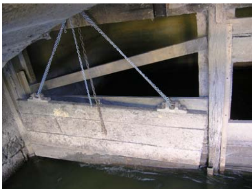
Vannage de la prise d'eau
