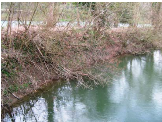
Berges érodées du canal de fuite
