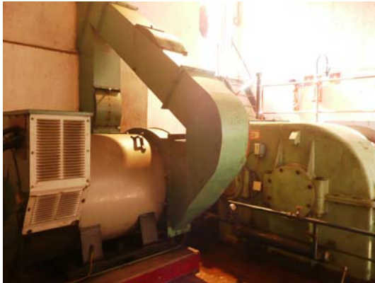
Turbine FRANCIS 520 KW de 1975
