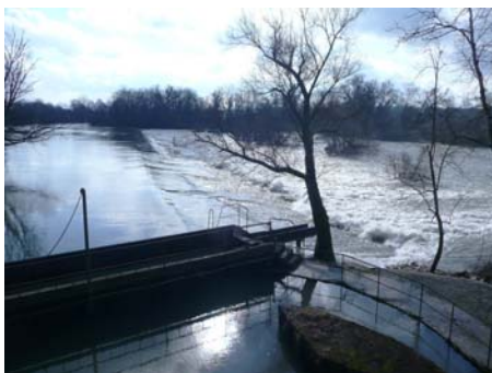
Prise d'eau , barrage et dégrilleur
