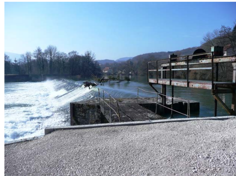
Barrage de l'usine hydroélectrique de Bourguignon
