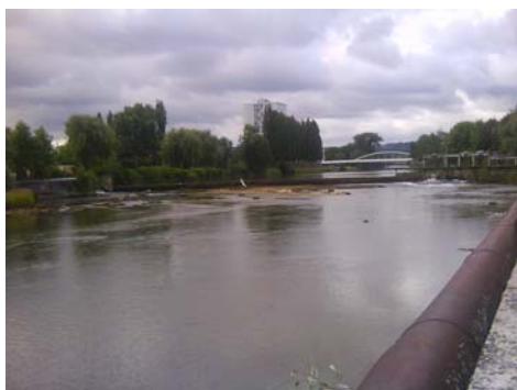
Barrage depuis l'aval
