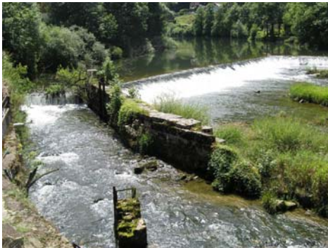
Brèche dans le canal d'amenée
