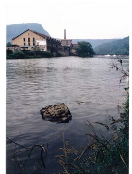
Papeterie et barrage, vue depuis l'aval.
