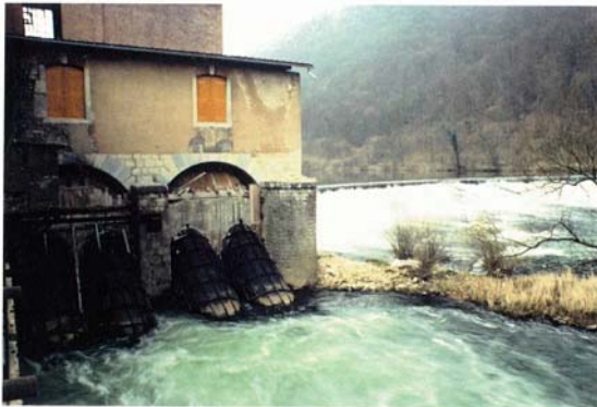
Sortie des turbines et départ du canal de fuite (Rive Droite)
