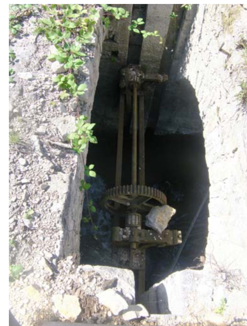
Vannage à l'entrée de la prise d'eau
