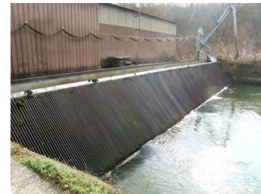
Prise d'eau avec dégrilleur
