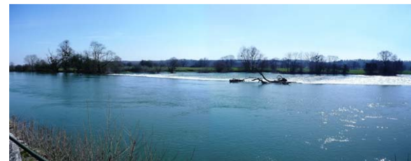
Barrage de l'usine hydroélectrique d'Audelange
