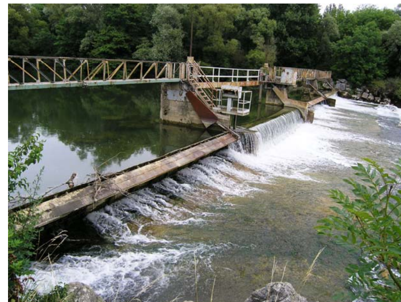
Barrage de l'usine hydroélectrique de Parcey
