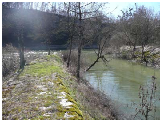
Canal de fuite
