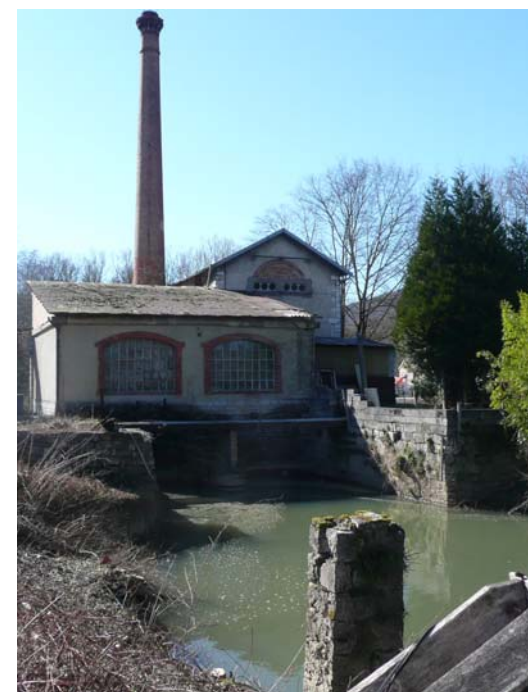
Canal d'amen  e et prise d'eau
