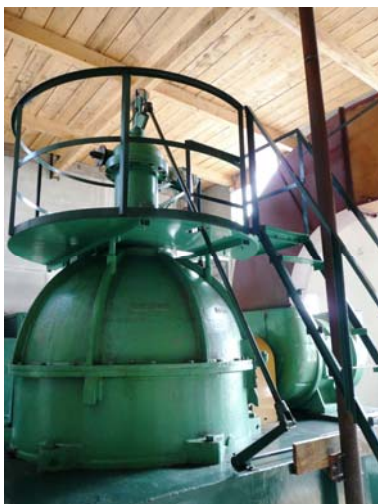
Multiplificateur de la turbine KAPLAN
