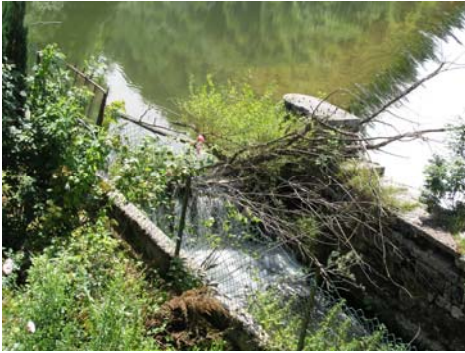
Embâcles à l'entrée du canal d'amenée
