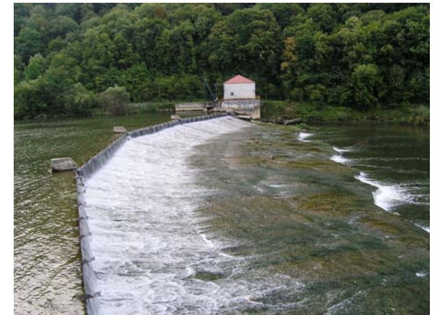
Le barrage avec clapets et usine en rive droite
