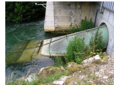
Sortie de la turbine KAPLAN (aspirateur)
