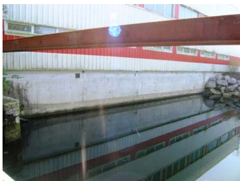
Ancienne prise d'eau condamnée
