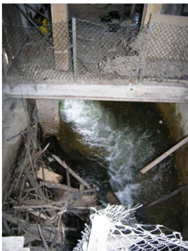
Vue intérieure de la prise d'eau latérale
