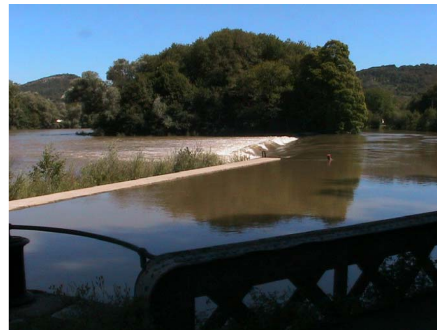
Barrage du moulin de Gouille
