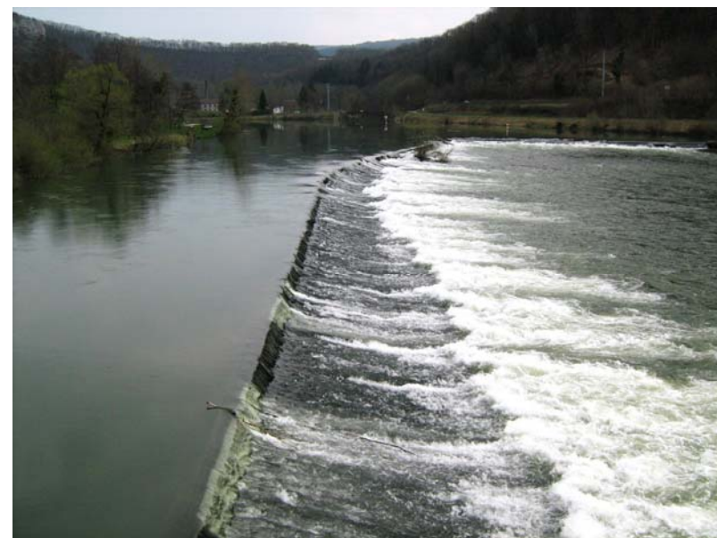
Barrage de l'usine hydroélectrique du moulin de Cour
