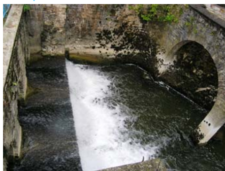
Ancienne installation des forges
