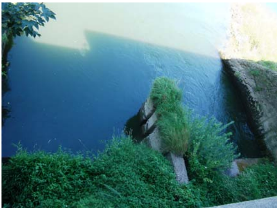
Sortie des chambres d'eau
