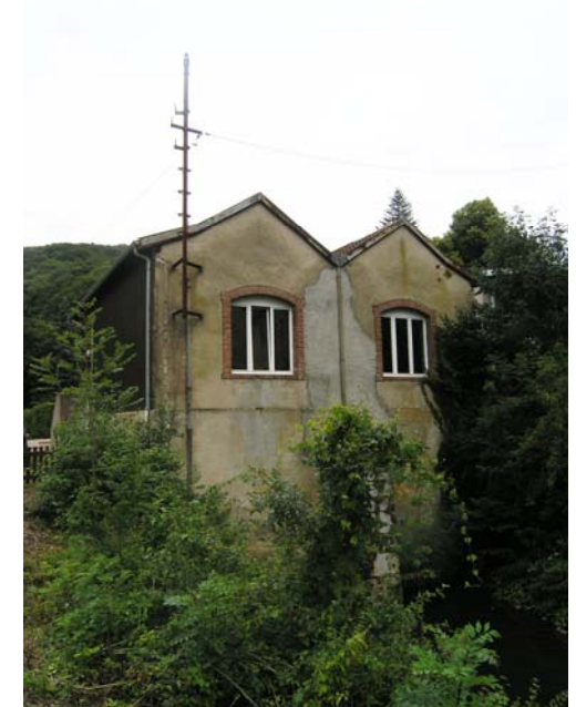
Le bâtiment des turbines, aujourd'hui converti en sanitaires pour le camping.
