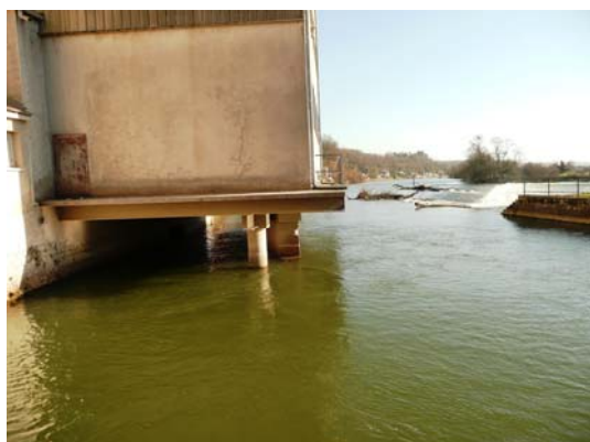
Prise d'eau agrandie en 1920. La partie de gauche correspond à l'ancien canal d'aménée
