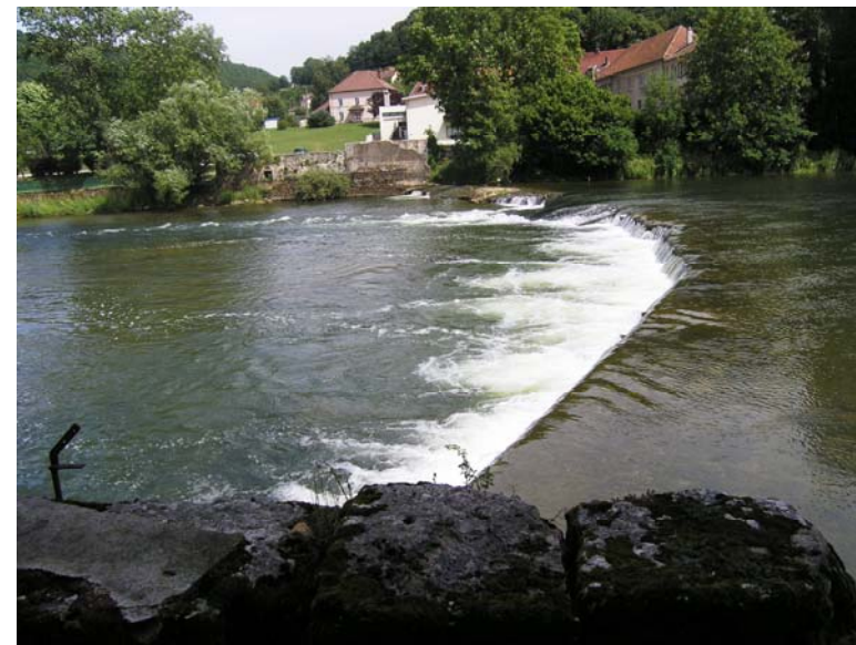
Barrage de l'ancienne usine DAHYS
