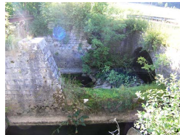
Déblais obstruant le passage de l'eau
