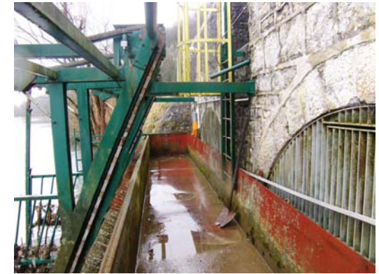
Prise d'eau avec dégrilleur
