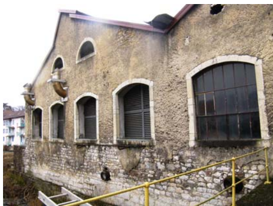
Bâtiments de production (vue extérieure)
