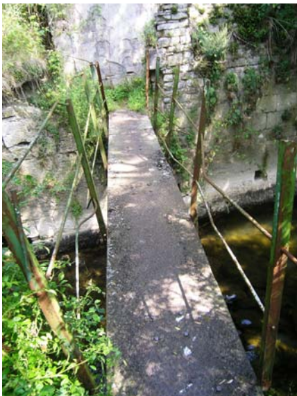
Passerelle, les emplacements des axes des roues sont encore visibles
