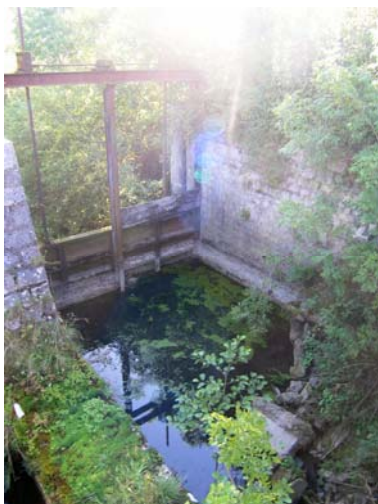
Vannage de la prise d'eau
