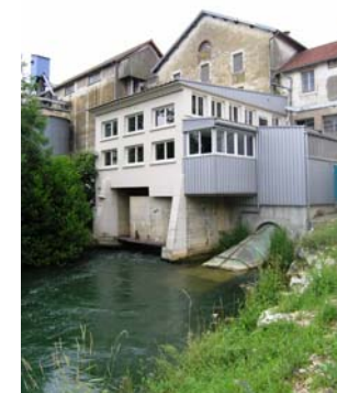
Bâtiments de production
