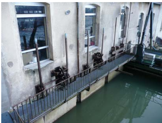
Prise d'eau turbine 200 KW (sous caserne des pompiers)
