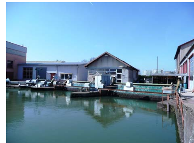
Prise d'eau avec vannage
