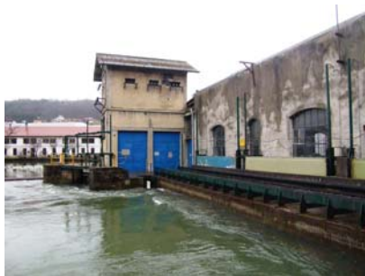
Tour destinée à être détruite et remplacée dans le cadre de la valorisation paysagère du site.
