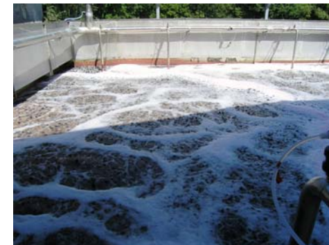
Bassin d'aération construit dans le canal de fuite
