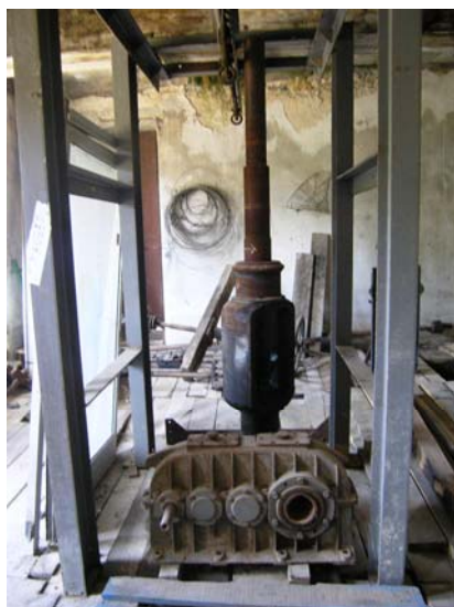
Anciennes installations : pivot d'arçon et multiplicateur
