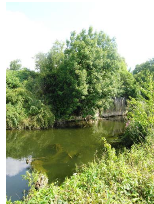
Canal de fuite
