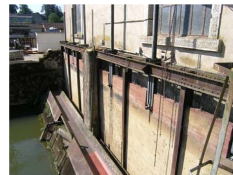
Dégrilleur manuel et vannage
