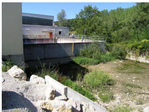
Ancien canal de fuite, bassin d'aération de la STEP de l'usine
