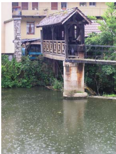
Vannage sur le barrage aval en rive gauche du Petit Doubs
