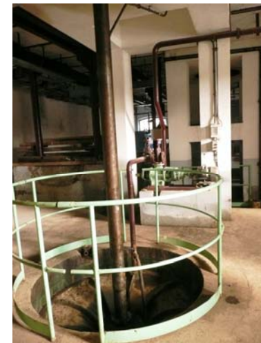
Arbre de transmission de la turbine vers les multiplicateurs (turbine 150 KW)
