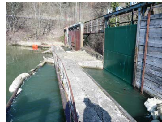
Prise d'eau avec vannage
