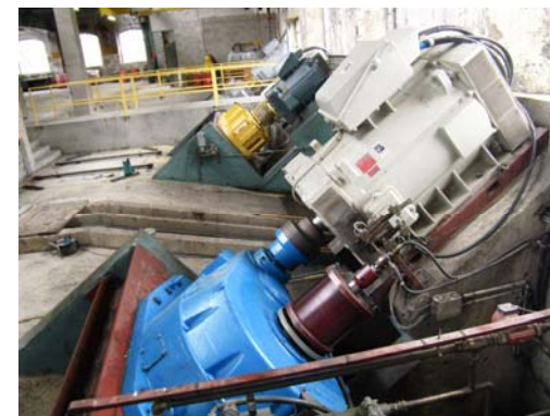
Multiplicateurs, au premier plan, installations de 1989. On distingue en arrière-plan les installations de 1993.
