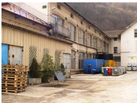
L'ancien canal d'amenée transite sous la cour
