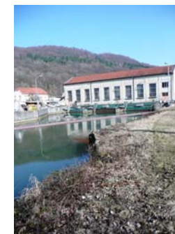
Bâtiments de production
