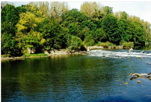
Site d'implantation de la nouvelle installation en rive droite
