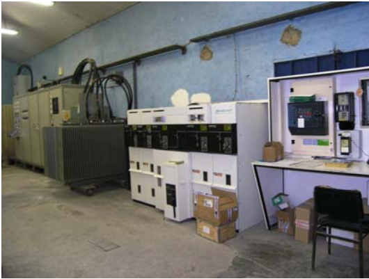
Transformateur et armoire électriques
