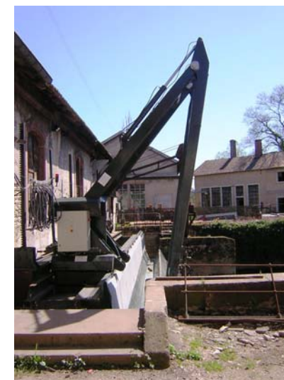
Dégrilleur automatique
