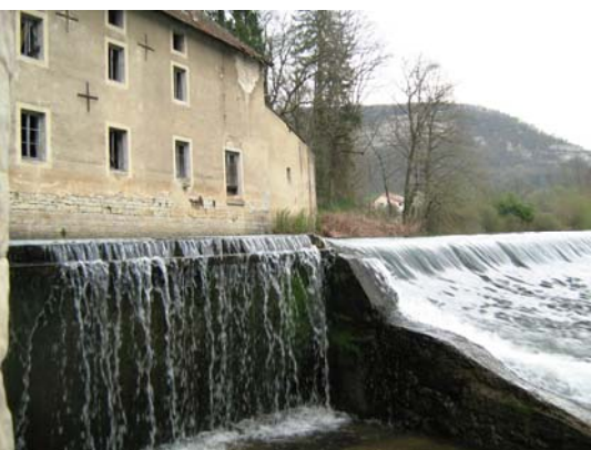
Déversoir de décharge
