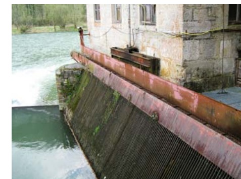
Vannage du canal secondaire et dégrilleur
