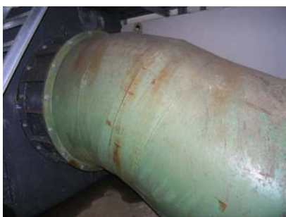
Emplacement de la turbine KAPLAN et aspirateur
