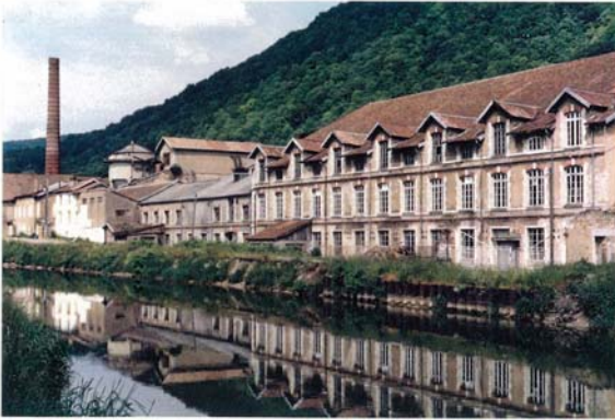
Vue générale des bâtiments de la papeterie
