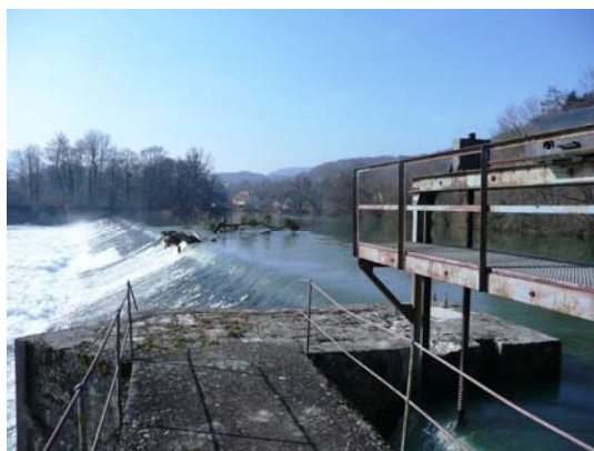
Problème d'embâcles et débris flottants
