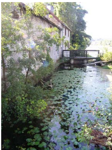
Prise d'eau vue de l'amont
