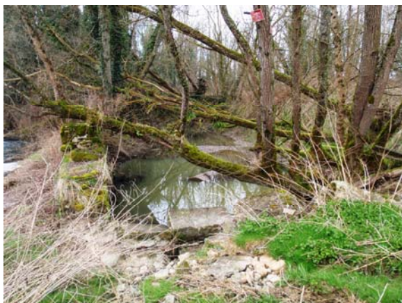
Prise d'eau comblée en Rive Droite
