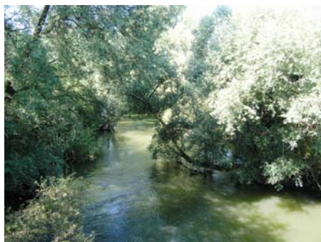
Partie aval du canal de fuite
