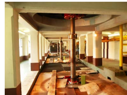
Arbre de transmission de la turbine vers les alternateurs
