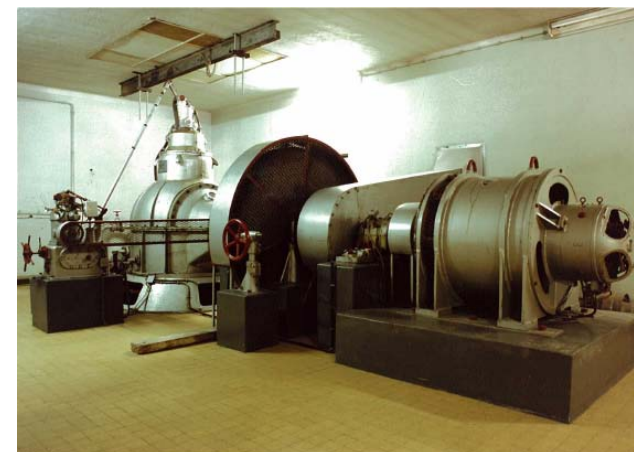
Groupe de production hydroélectrique
