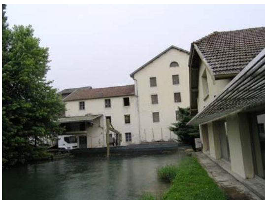
Moulin, vue générale avec dégrilleur
