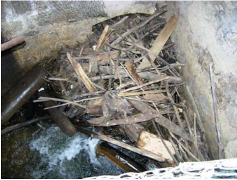
Embâcles en sortie de prise d'eau
