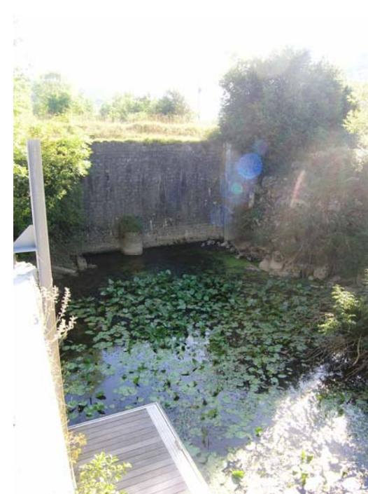
Sortie des chambres d'eau et canal de fuite
