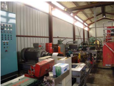
Vue d'ensemble des 5 turbines
