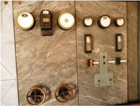
Anciens tableaux électriques
