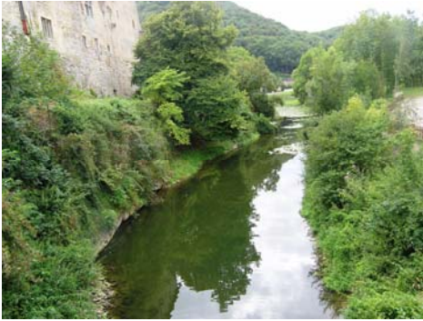
Canal de fuite
