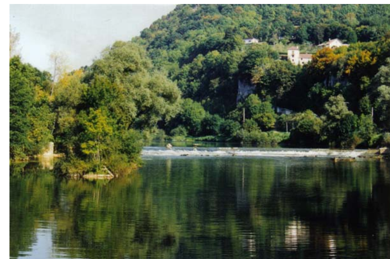
Barrage de l'usine hydroélectrique de Chaux-les-Clerval
