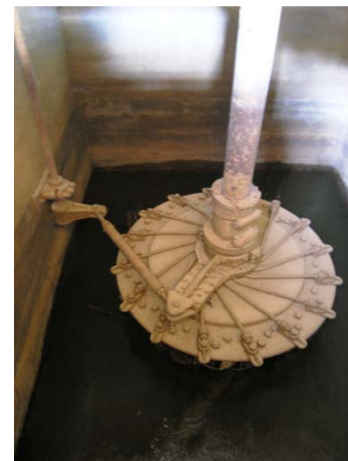
Toit de la turbine et réglage des directrices
