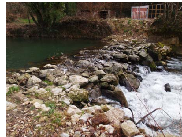
Enrochement à l'entrée de la prise d'eau en Rive Gauche
