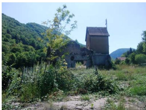
La turbine était implantée dans le canal souterrain, situé en contrebas de la zone grillagée
