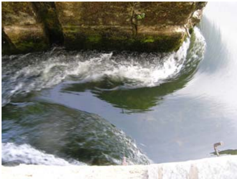
Canal de décharge
