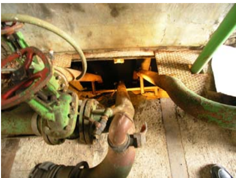
Prise d'eau pour l'eau de process
