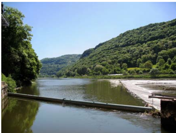
Barrage et drome flottante, vue vers l'amont
