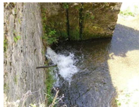
Canal de fuite et sortie des chambres d'eau
