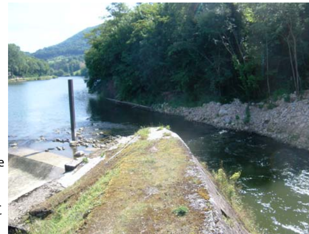
Entrée du canal d'amenée
