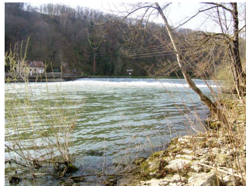
Barrage de l'usine hydroélectrique de Rang dans son environnement
