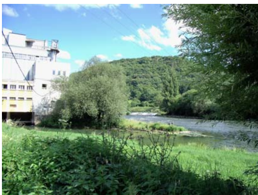
Canal de fuite et restitution au Doubs
