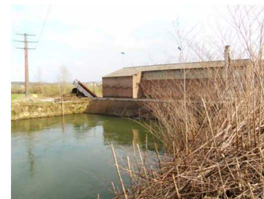
Vue générale de la prise depuis la rive droite du canal d'amenée
