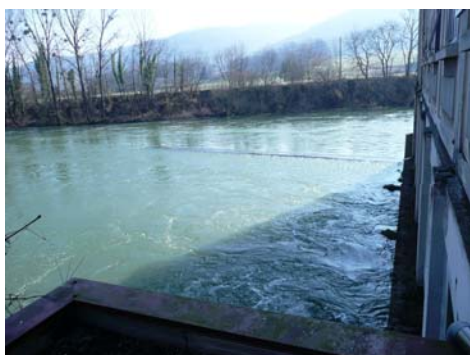
Canal de fuite, hautes eaux
