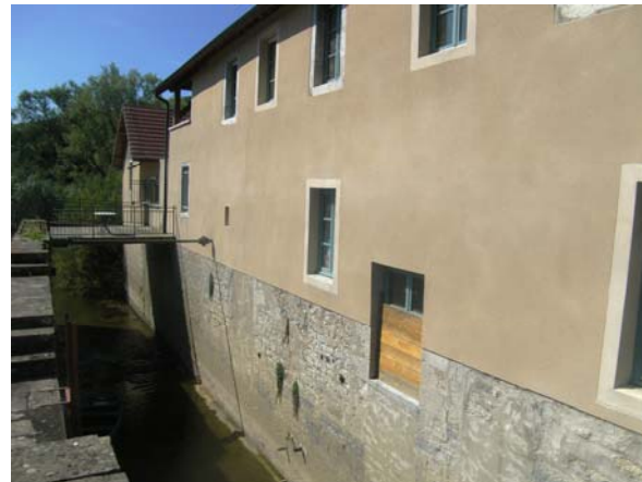
Coursier et bâtiment, vue vers l'aval
