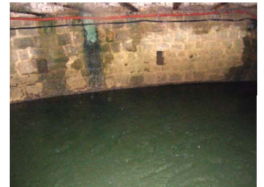
Vue intérieure du canal d'amenée
