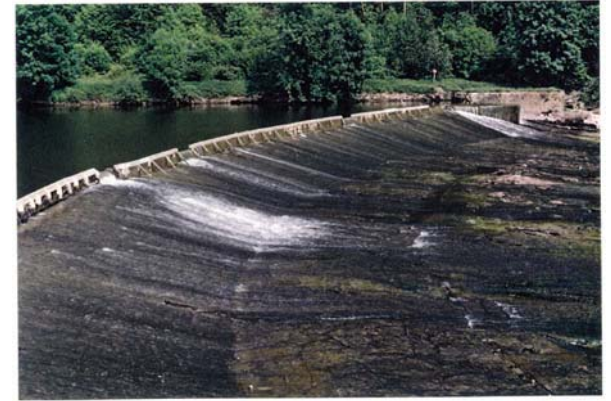
Le barrage avant mise en place des clapets
