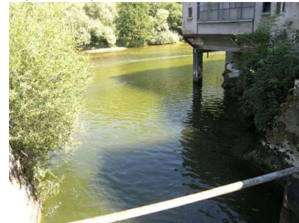
Aval du vannage de décharge
