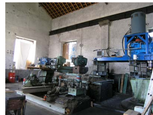
Groupes de production, G1 vertical et G2 à renvoi d'angle
