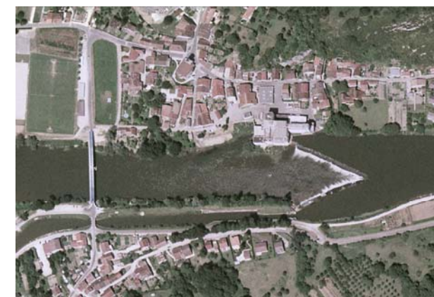
Vue aérienne du site montrant le moulin, le barrage, le Doubs et le canal du Rhône au Rhin en rive gauche du barrage
