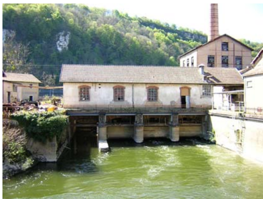
Sortie des chambres d'eau
