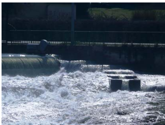
Passé à poissons non fonctionnelle
