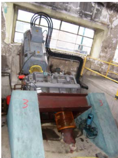
Groupe de production installé en 1993
