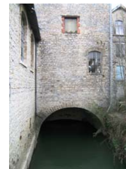
Sortie de la chambre des turbines vers le canal de fuite.
