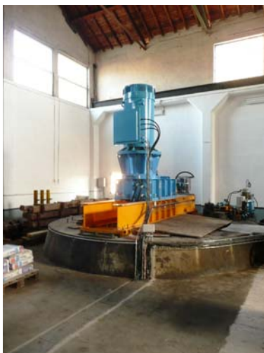
Groupe de production rénové en 2008
