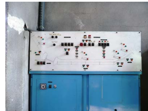
Panneau de commande des clapets automatiques et du vannage
