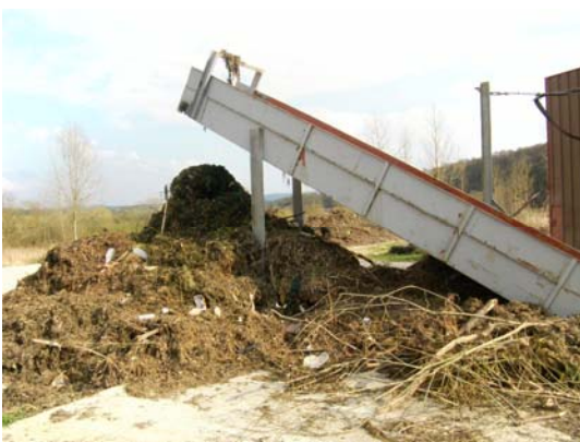
Dégrilleur et amoncellement de débris flottés
