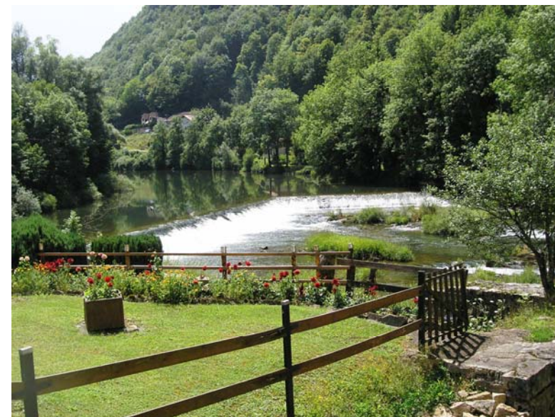
Site du Moulin Neuf, le barrage
