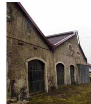
Bâtiments de production
