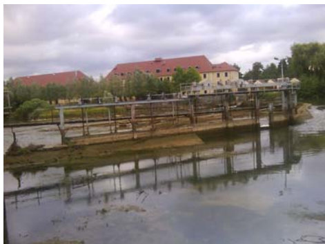
Barrage depuis la prise d'eau
