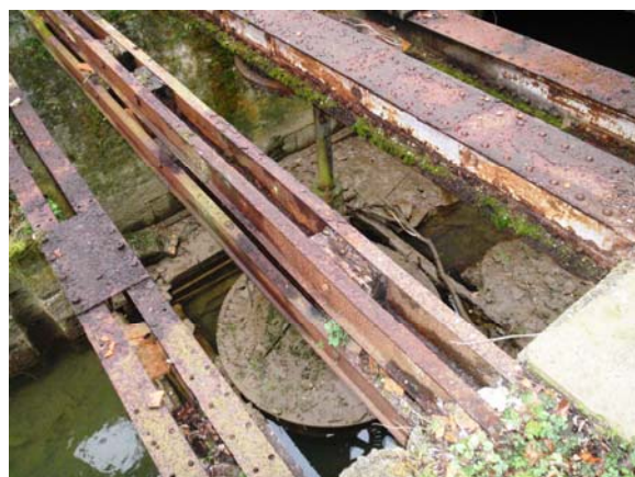
Turbine Rive Droite
