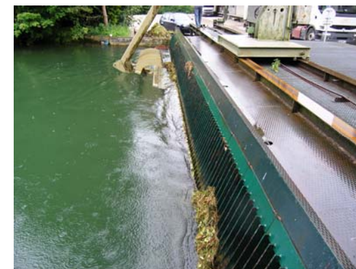
Entrée d'eau avec dégrilleur
