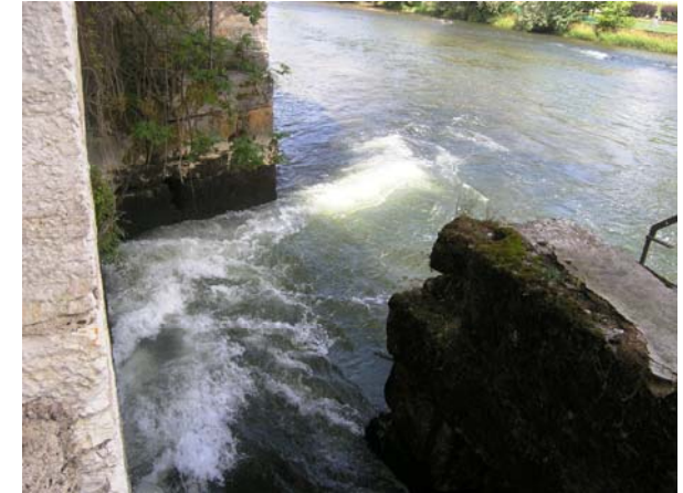
Sortie de la prise d'eau et du canal de décharge
