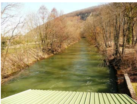
Sortie des chambres des turbines vers le canal de fuite
