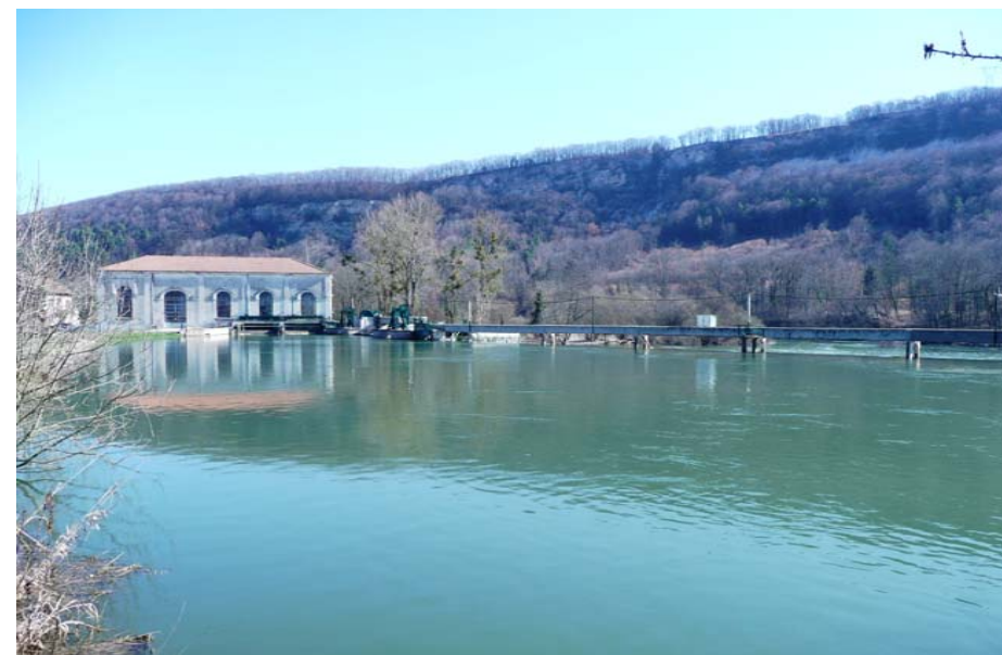
Vue générale de l'usine hydroélectrique de Mathay
