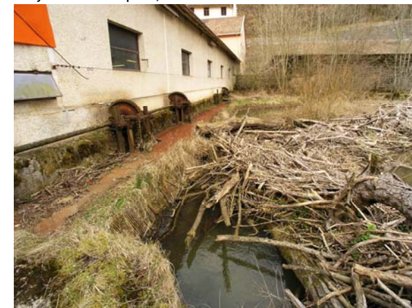
Prise d'eau avec dégrilleur, presque totalement comblée d'embâcles
