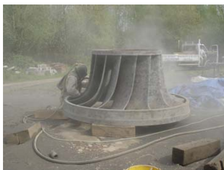
Turbine FRANCIS en cours de sablage
