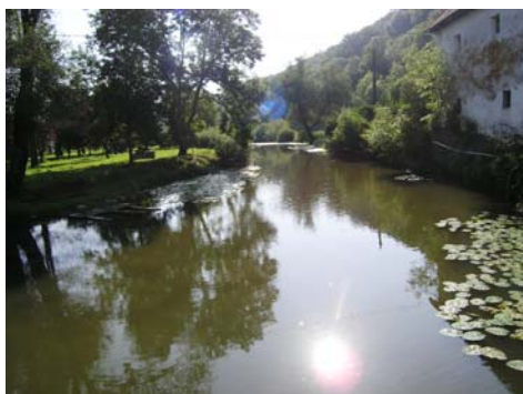
Canal d'amenée, vue vers l'amont
