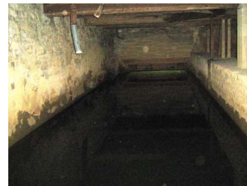
Vue intérieure du canal secondaire
