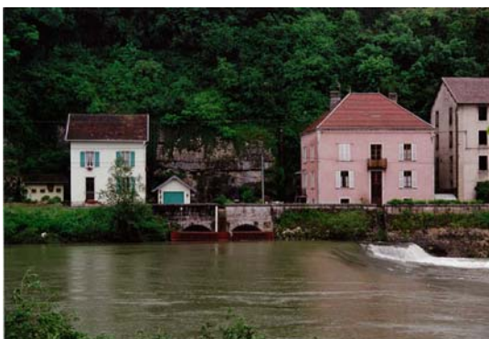
Prise d'eau, vue depuis la berge opposée
