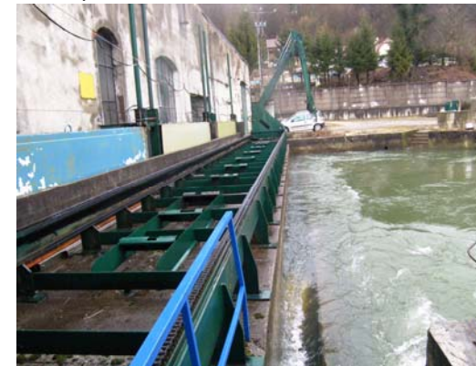
Prise d'eau avec dégrilleur
