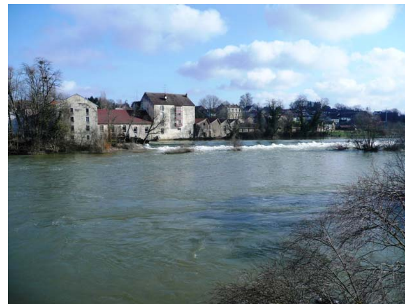
Barrage de l'usine hydroélectrique d'Orchamps
