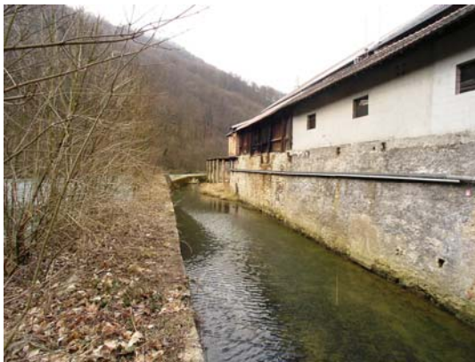
Canal de fuite
