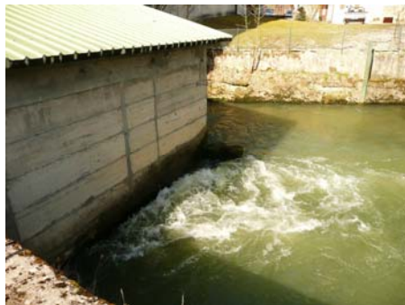
Sortie de la turbine FRANCIS 520 KW vers le canal de fuite
