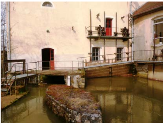
Prise d'eau turbine 150 KW. A gauche, l'ouverture de la prise d'eau de l'ancienne turbine, condamnée.
