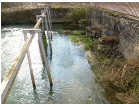
Sortie des chambres d'eau
