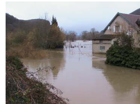
Lors de crues, le bâtiment est inondable
