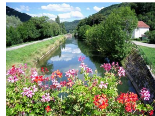
Le canal de navigation permet d'assurer le continuum ichtyologique en complément du barrage franchissable
