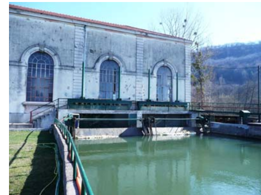
Prise d'eau et dégrilleur
