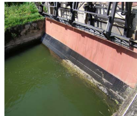
Dégrilleur automatique
