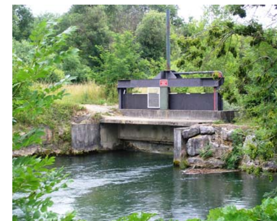
Vannage régulant le débit à l'entrée du bief d'amenée
