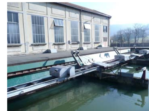
Dégrilleur automatique
