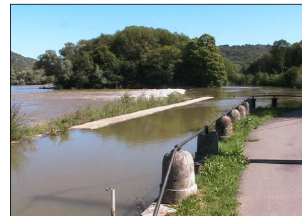
Détail de la Rive Gauche avec prise d'eau
