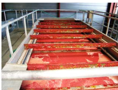
Station d'épuration de la papeterie, bacs de traitement
