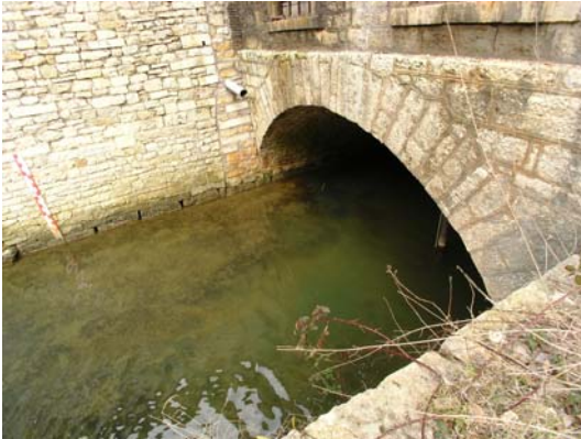
Sortie de l'ancienne chambre des turbines
