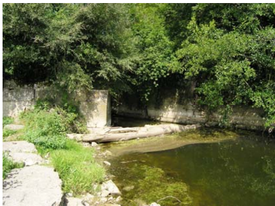
Ancienne prise d'eau
