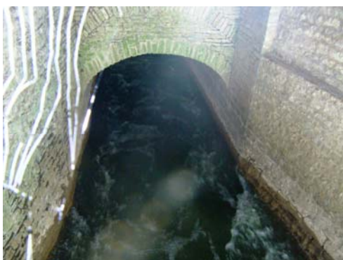
Partie souterraine du canal de fuite, vue vers l'amont
