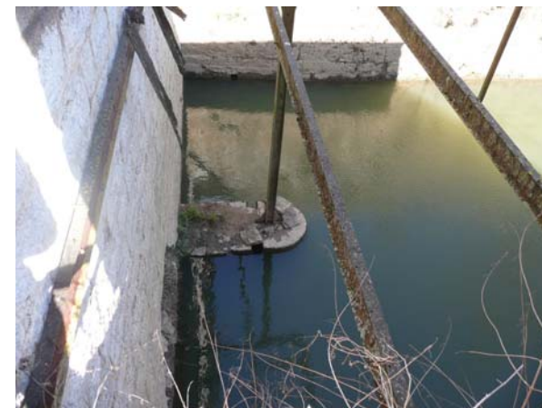
Sortie de la chambre des turbines
