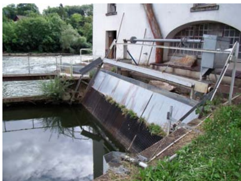
Prise d'eau avec dégrilleur
