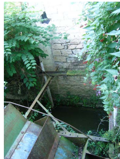
Sortie de la chambre des turbines et roue à aube non fonctionnelle
