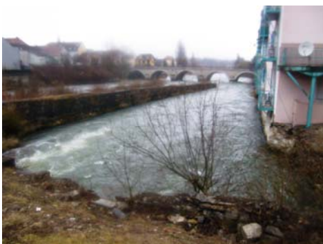
Canal de fuite
